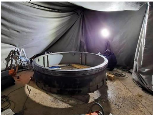
Рисунок 7. Нанесение покрытия MODENGY 1003 на резьбу конусных дробилок
